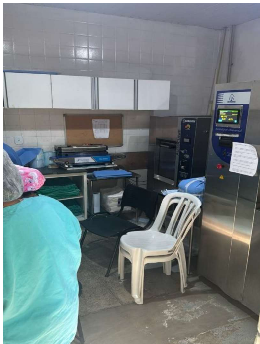
CENTRAL DE MATERIAL ESTERELIZADO
